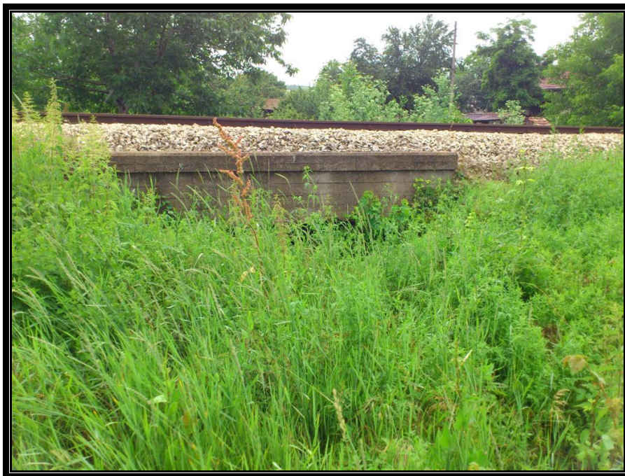
Водосток под жп-линията / страна отток/
